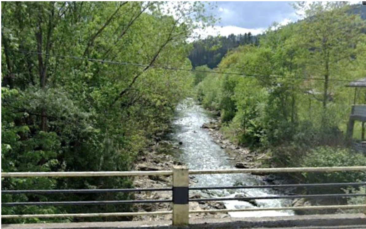
Figura nr. 3-15 Corpul de apă Bistricioara (Capu Corbului, Bistricioara) în zona de intersectare cu proiectul
