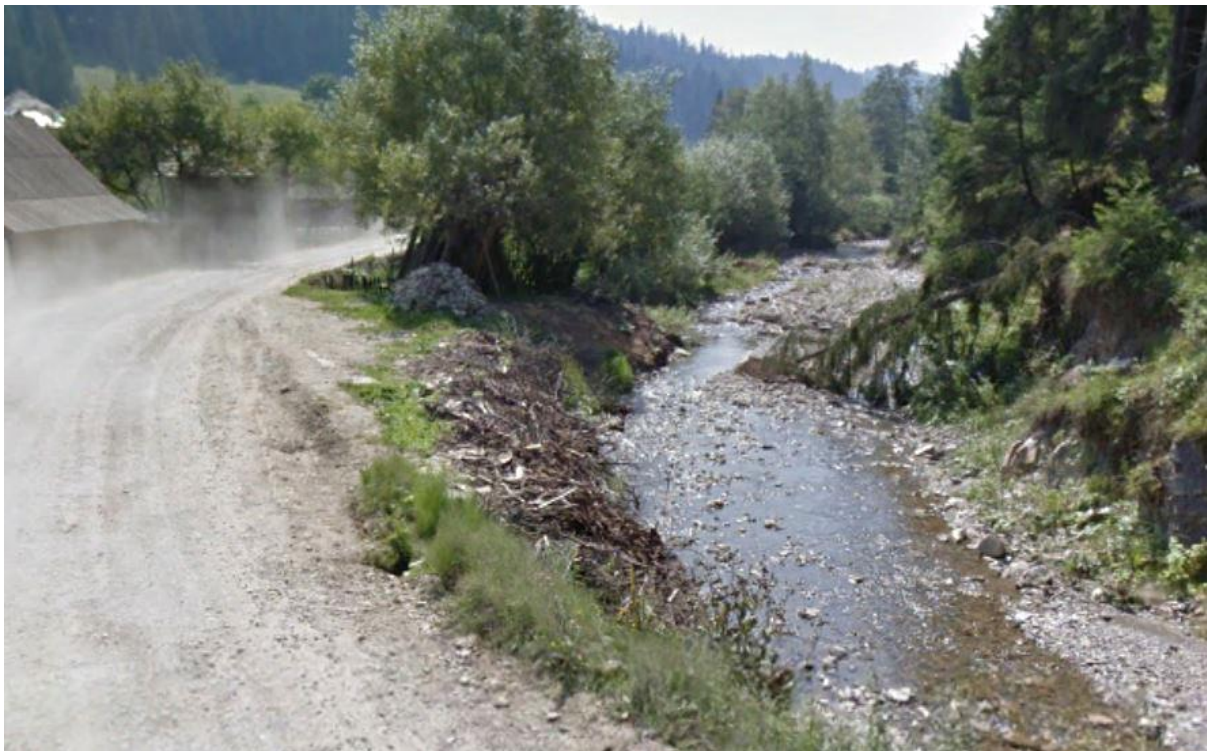
Figura nr. 3-17 Corpul de apă Bolătău în zona de intersecție cu proiectul
